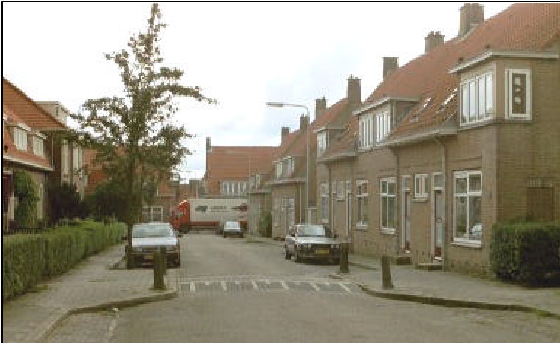
Figuur 4.1 Eengezinswoningen in hoge dichtheden in Geitenkamp
